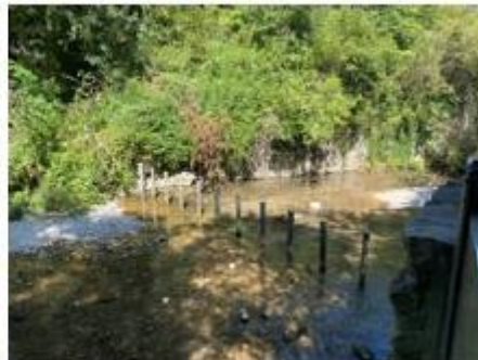
Figure 4 : Exemple de suivi de routine d'un ouvrage de type piège à embâcle sur le torrent du Furon (38).
